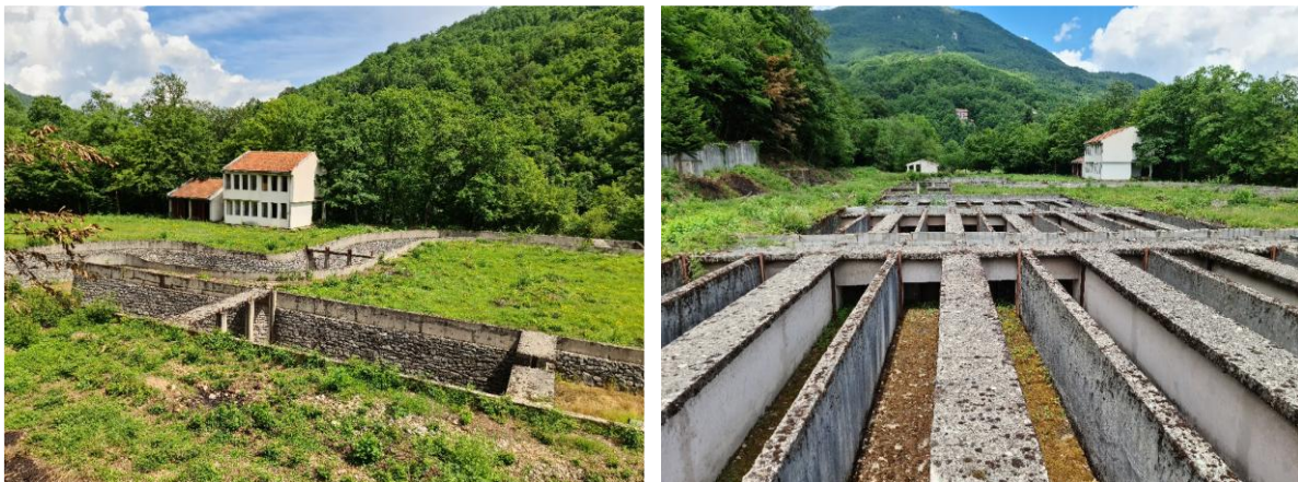
Слика 1. Постојеће стање мрестилишта (Архива Завода за водопривреду, јун 2023. године)
