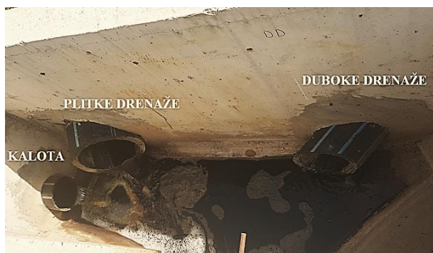
Slika 3. Ulaz drenažnih sistema u zbirno okno MS1 (Serdarević, 2016)
