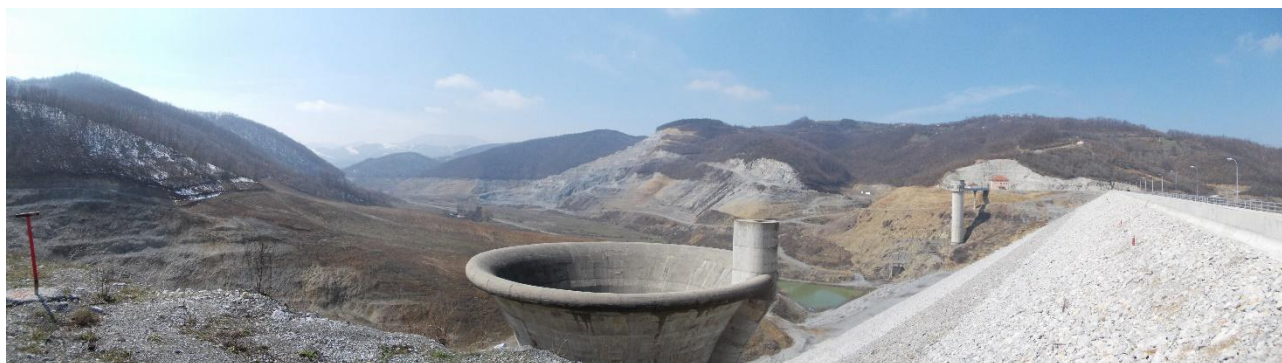
Slika 2. Pogled na nasutu branu Rovni i njen šahtni preliv u desnom boku
