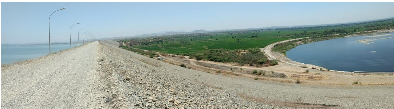
Slika 5. Brana Poechos – pogled na slapište glavnog preliva i levi nasuti deo brane pre izvođenja radova na njenoj kruni
