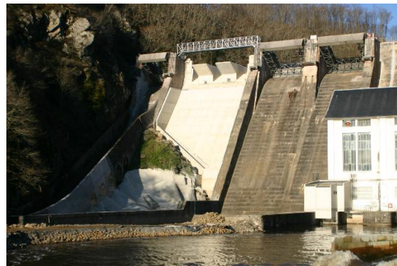
Slika 9. Brana Saint-Marc, Francuska – pre i nakon rekonstrukcije
