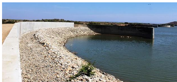
Slika 7. Betonski parapet na kruni brane Poechos
