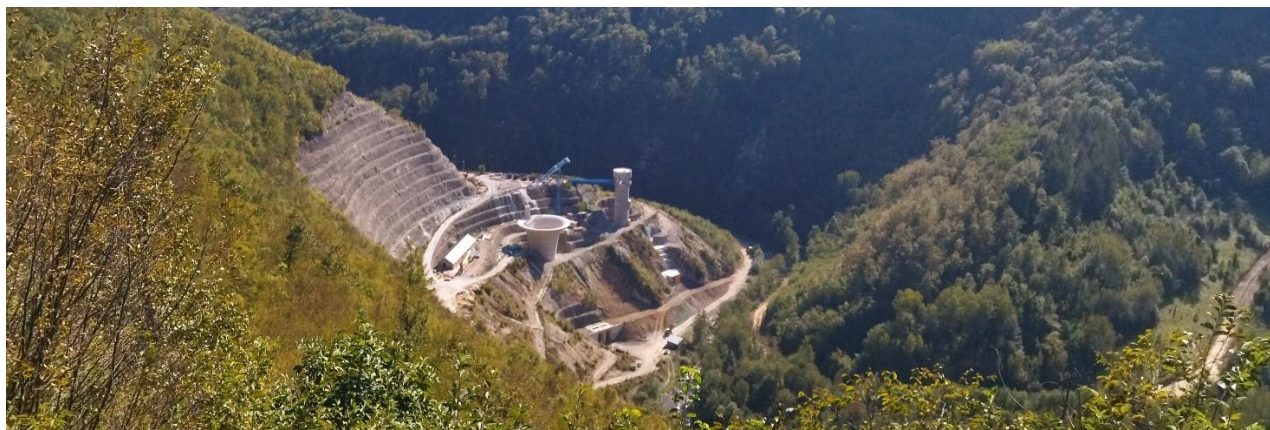
Slika 3. Pogled na profil brane „Arlje”, izvedene objekte na levom boku
