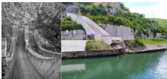
Slika 1. Ski odskok sa horizontalnim skretanjem mlaza – Vnda Nova Dam in Portugal (lijevo) i “standardni” ski odskok – brana Bočac u Republici Srpskoj (desno)
