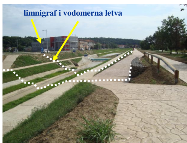
Slika 2. Regulisano korito za veliku vodu u blizini h. s. Ub sa naznačenim računskim preseccima (sliku ustupilo JVP „Srbijavode“)
