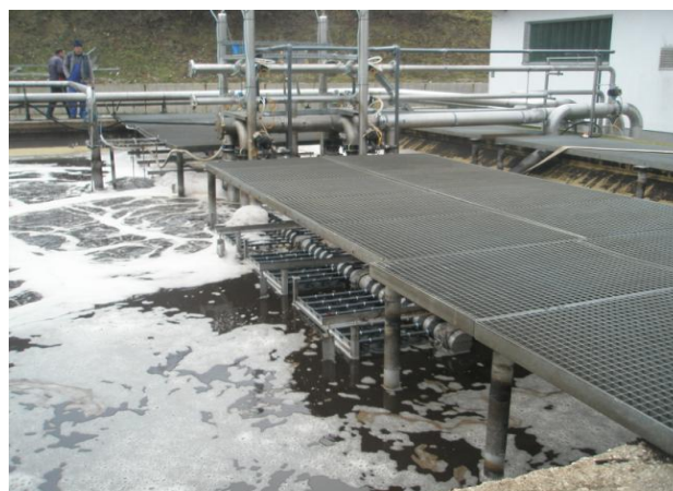
Slika 1. MBR uređaj u pogonu 2008.-2011. na Smiljevićima
