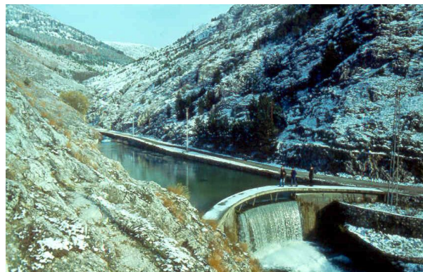
Slika 3. Lučna pregrada
