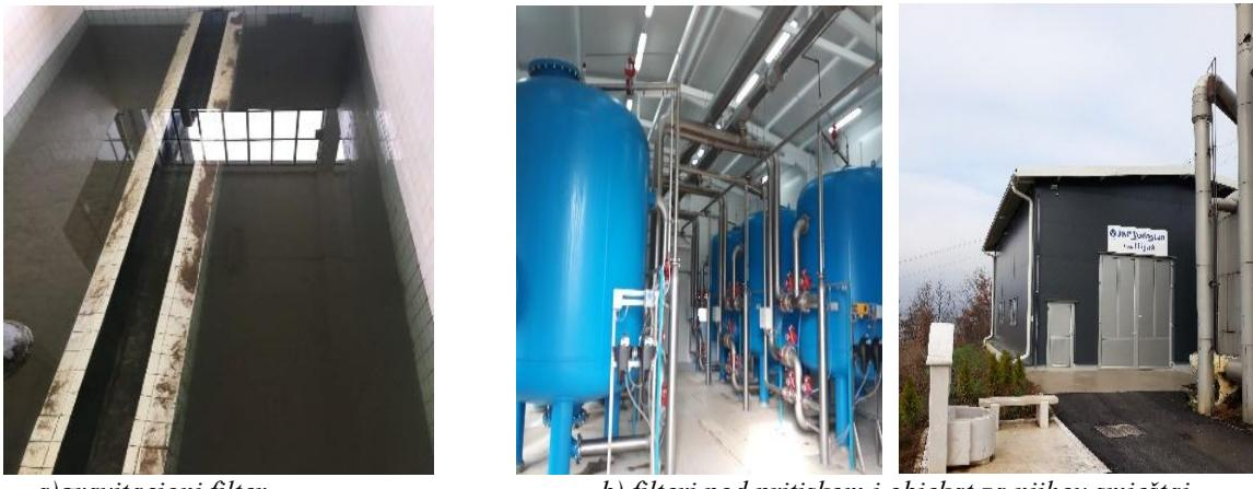
*a) gravitacioni filter**b) filteri pod pritiskom i objekat za njihov smještaj*
