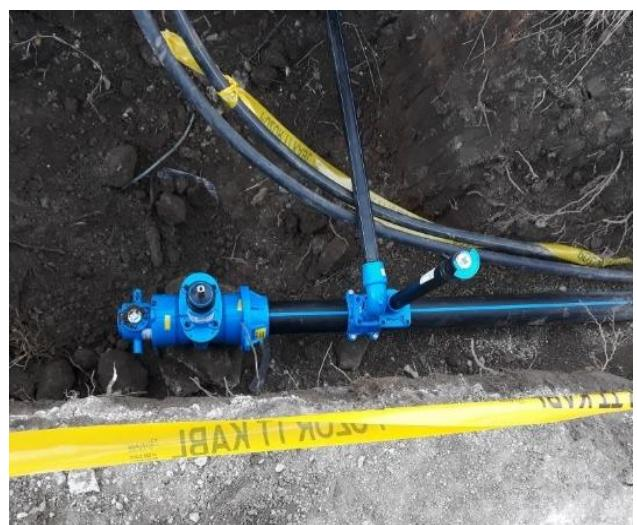
Slika 13. Izvedba kućnog priključka
