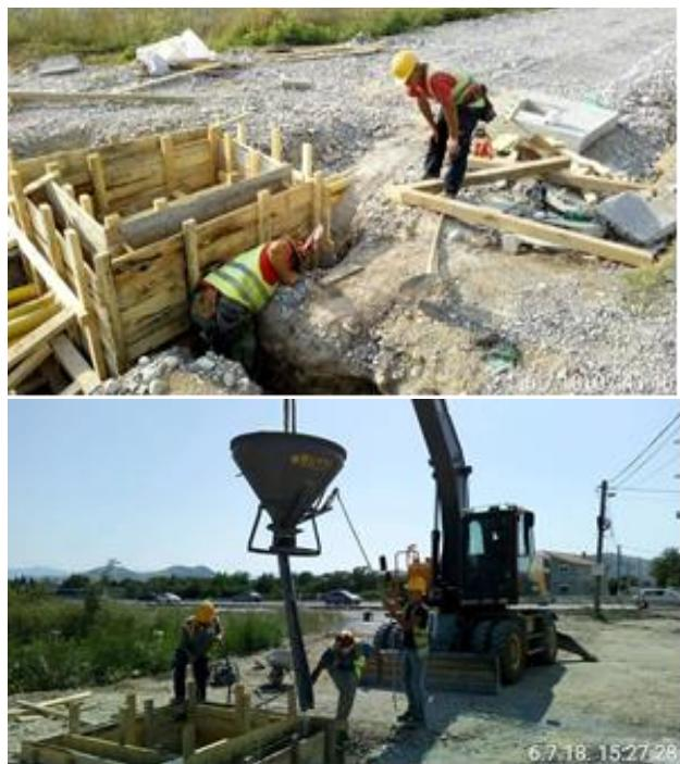
Slika1. Proces izgradnje vodovodnog okna [12]
