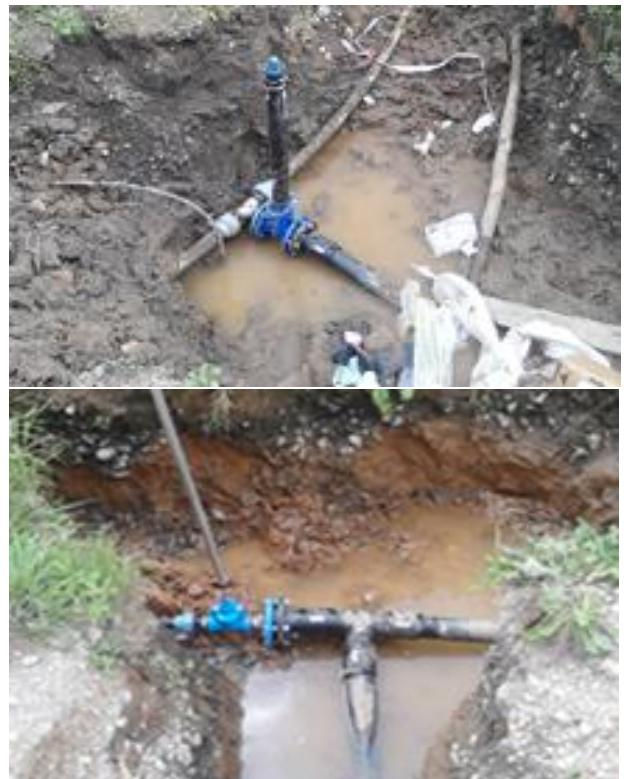
Slika 2. Ugradnja fazonskih komada i armatura bez okna
