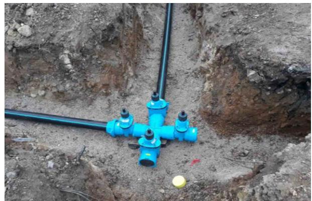
Slika 12. Detalj ugradnje čvora po BAIO sistemu u sklopu rekonstrukcije mreže Visoko – faza II
