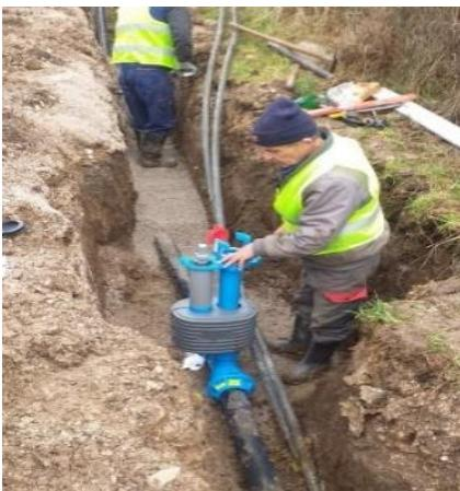
Slika 11. Ugradnja podzemnog hidranta na trasi
