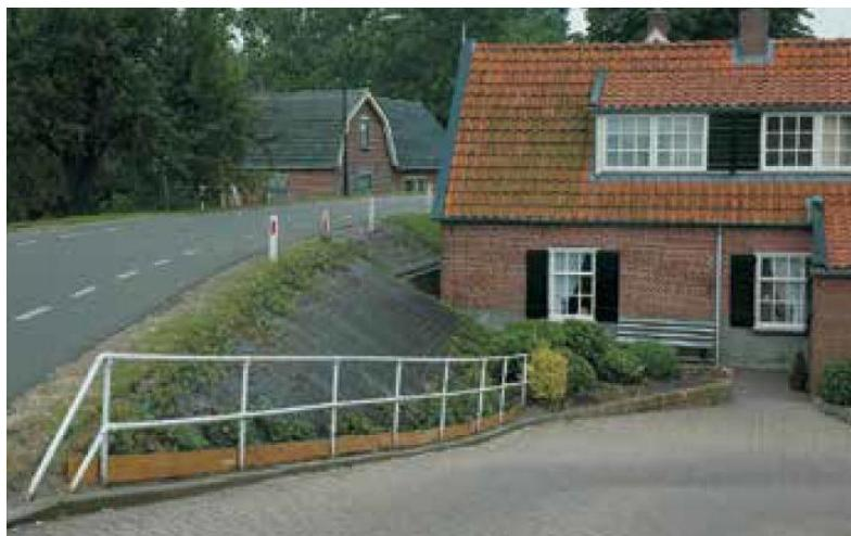
Slika 24. Povjesna građevina na trasi nasipa zaštićena potpornim zidom
