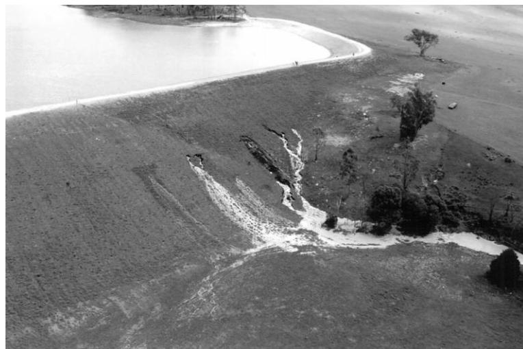
Slika 15. Procjeđivanje na zračnoj strani nasipa [5]
