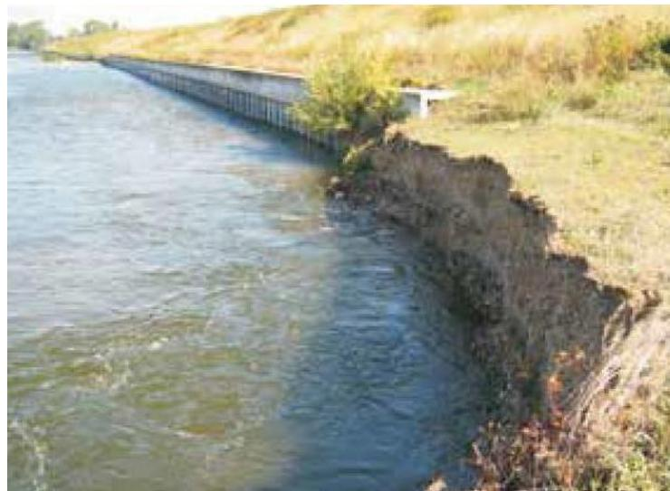
Slika 11. Obrušavanje uzvodnog pokosa uslijed vanjske erozije [1]
