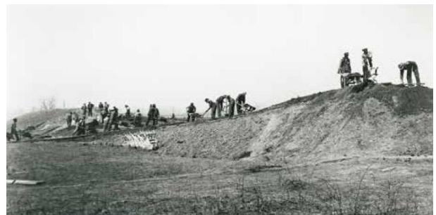
Slika 1. Izgradnja nasipa bez pomoći mehanizacije [1]
