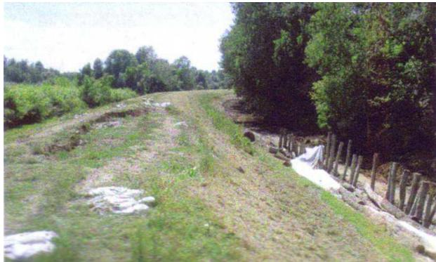
Slika 44. Zaštita kosine od klizanja nizom drvenih pilota [5]
