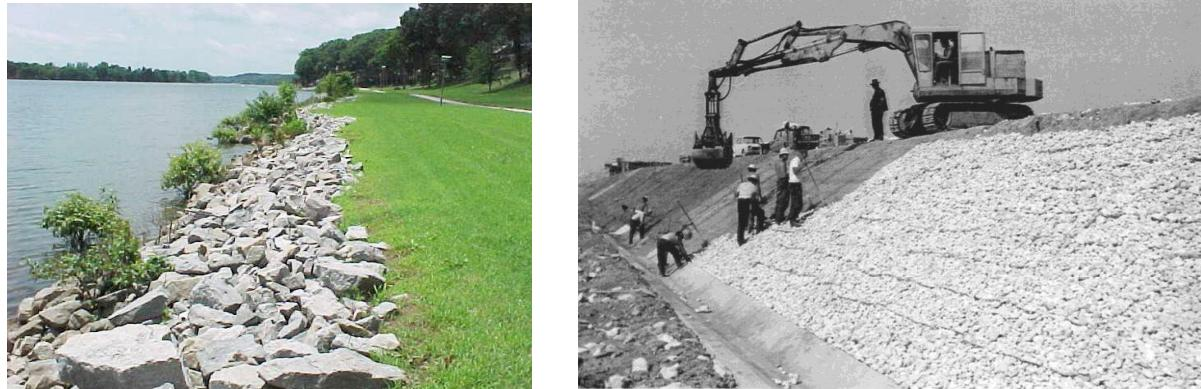
Slika 34. Rip-rap, lijevo i gabioni, desno na uzvodnim kosinama nasipa
