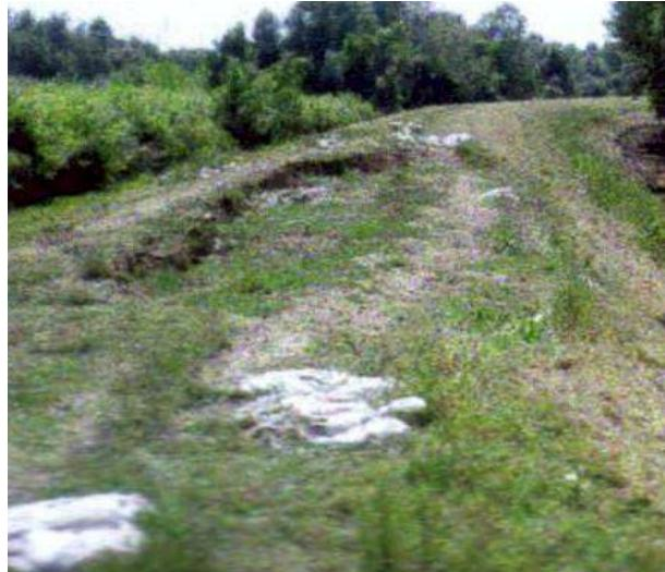
Slika 37. Pukotina u kruni nasipa koja ukazuje na moguće klizanje nizvodnog, zračnog pokosa
