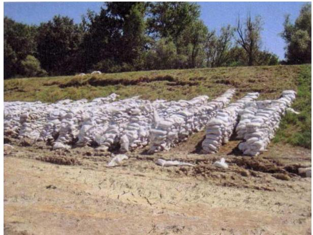
Slika 43. Klizište na nizvodnoj (zračnoj) strani nasipa uslijed djelovanja procjeđivanja kroz nasip pri ekstremno visokom vodostaju. Zaštita od hidrauličkog sloma (prekomjernog procjeđivanja) i dodatno opterećenje nožice [5]
