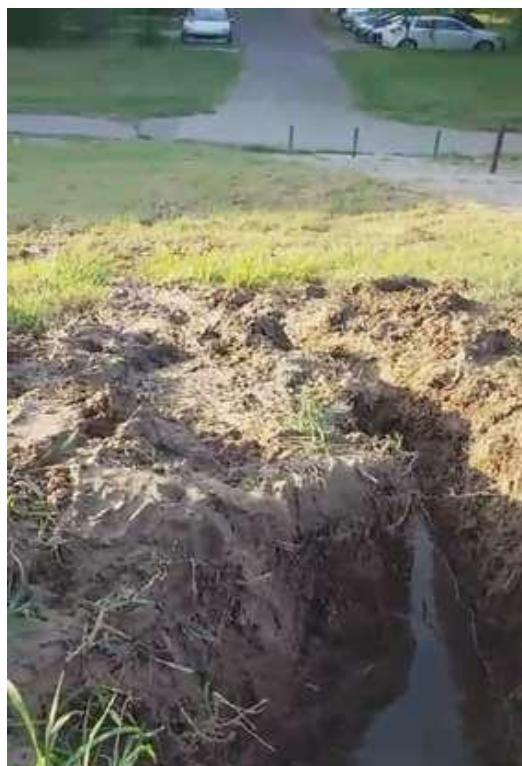
Slika 20. Tragovi namjernih teških oštećenja nasipa
