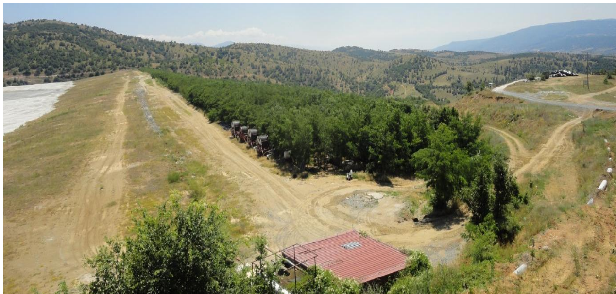
Слика 1. Круна бране дужине 930 m, седиментно језеро и рекултивисана низводна косина јаловишне бране Тополница
