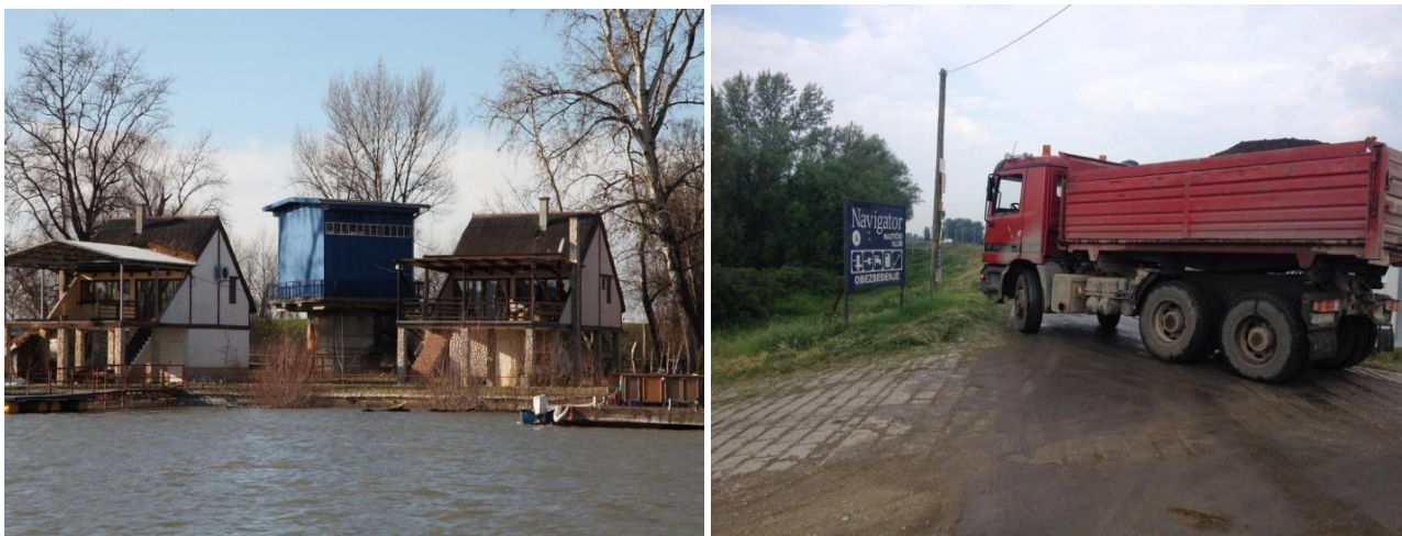
Слика 4. Злоупотреба водног земљишта и насипа; лево: бунар београдског водовода опкољен илегалним кућама; десно: разарање савског насипа који није димензионисан за саобраћај тешких и других возила, осим сервисних возила
