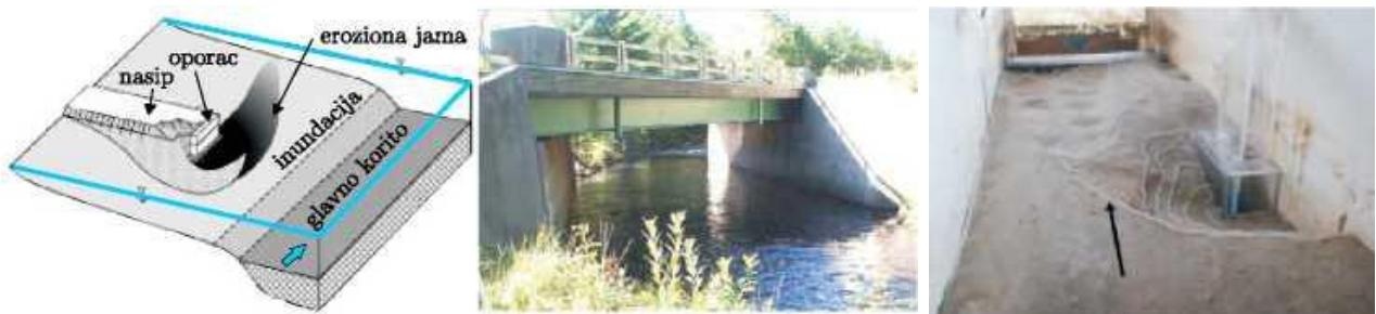
Slika 8. Mostovski oporci; sleva udesno: skica erozije oko opora u inundaciji; oporci u glavnom koritu [18]; ispitivanje lokalne erozije oko vertikalnog opora u laboratorijskom kanalu [6].
