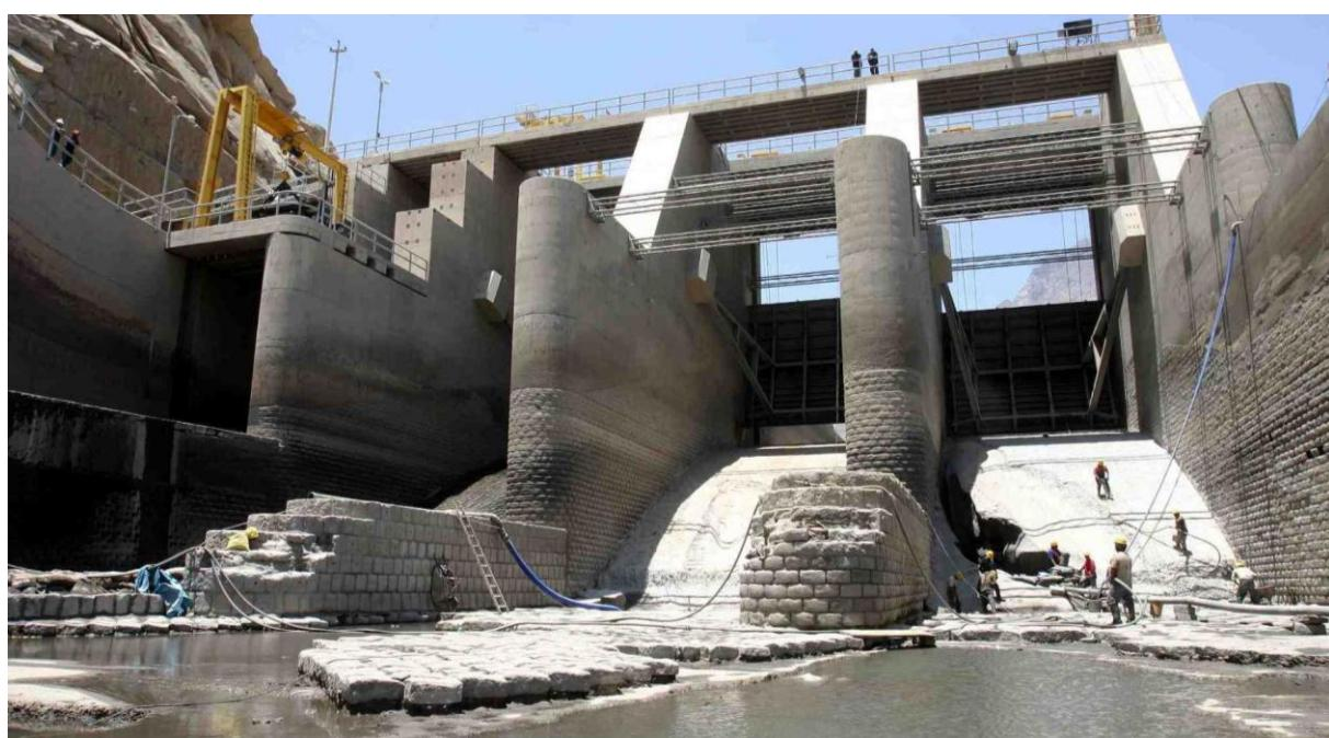
Slika 6. Brana Chavimochic, oštećenja preliva i slapišta usled nedovoljne zaštite
