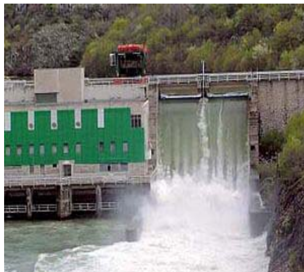
Slika 15. HE Đale, preljev i pogonska zgrada
