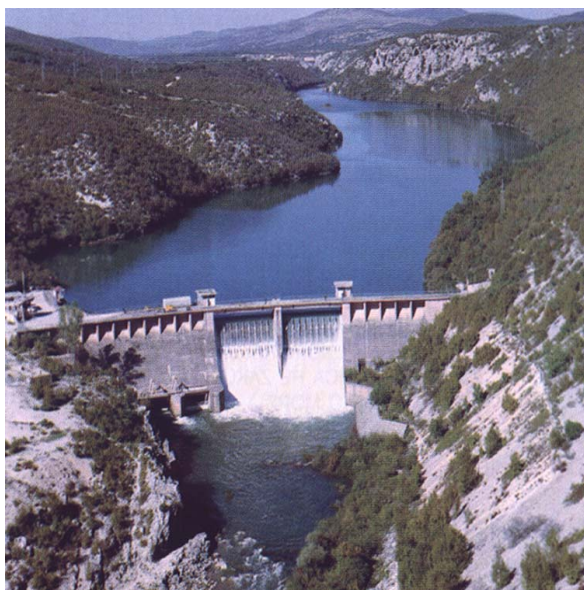
Slika 16. Brana i jezero Prančevići [9]
