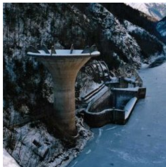
Slika 4. Neobična kombinacija preljeva (bočni i kružni) uz branu Pontesei [3]
