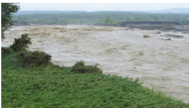
Slika 7. Prodor vode na mestu oslabljenog nasipa
