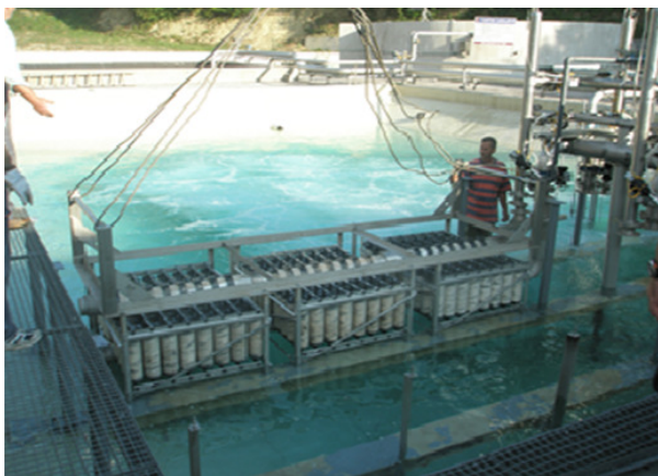
Slika 9. Spuštanje membrana u čistu vodu na MBR postrojenju deponije u Sarajevu (Serdarević, 2011)
