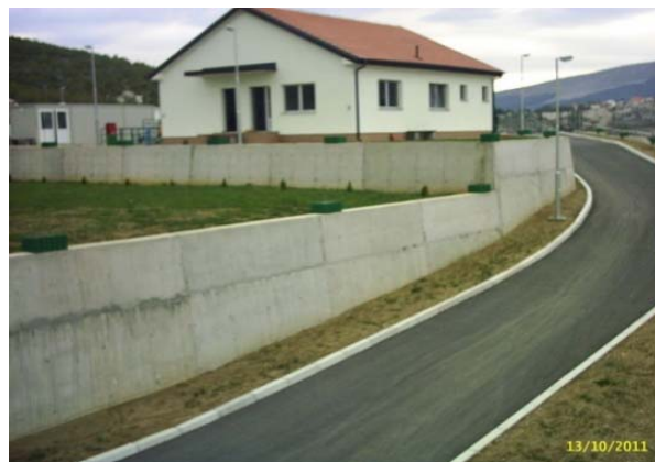
Slika 6. Potporni zidovi u krugu postrojenja
