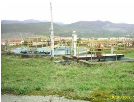
Slika 2. Postrojenje za predtretman, AD "Bilećanka"
