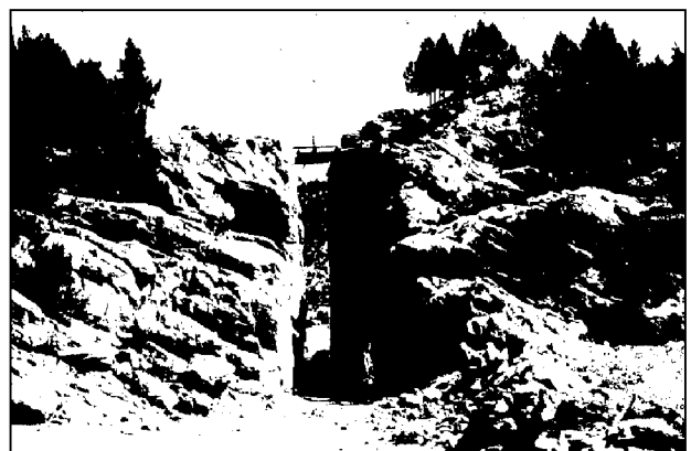
Slika 1. Enif polje, Turska. Proseka u krečnjaku radi odvodnje polja.
