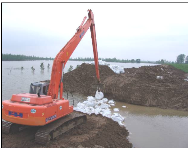
Slika 7. Provizorno zatvaranje preseka nasipa na Tamišu
