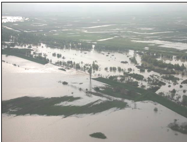
Slika 2. Prodor desnoobalnog nasipa Tamiša na km 8+250, na rumunskoj teritoriji.
