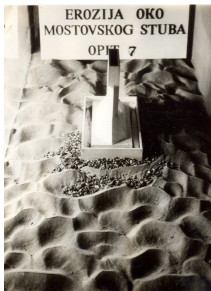
Slika 1. Hidraulički modeli za ispitivanje lokalne erozije dunavskog korita oko mostovskih stubova i varijantnih rešenja zaštite stubova; levo: model iz 1974. godine, stub S41 (pogled nizvodno); desno: model iz 2008. godine, stubovi S41 i S41' (pogled uzvodno). Oba modela su izradjena u nedistordovanoj razmeri 1:40. Slika desno prikazuje deformaciju korita u toku izgradnje stuba S41', sa osiguranjem korita oko zagata tepihom od krupnog kamena [2,4,5].
