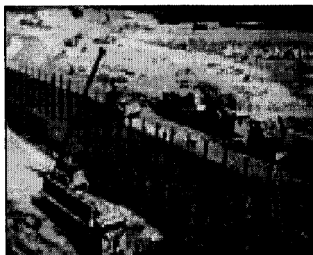
Slika 9. RCC brana Carrol E. Ecton - Montaža prvih membranskih betonskih panela za oblaganje
