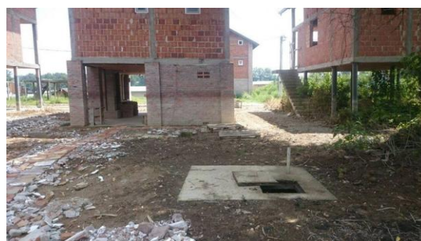
Slika 5: Senkrupi i upojne jame u izvorišnom aluvionu u zoni bunara Beogradskog vodovoda. Nečuveno!
