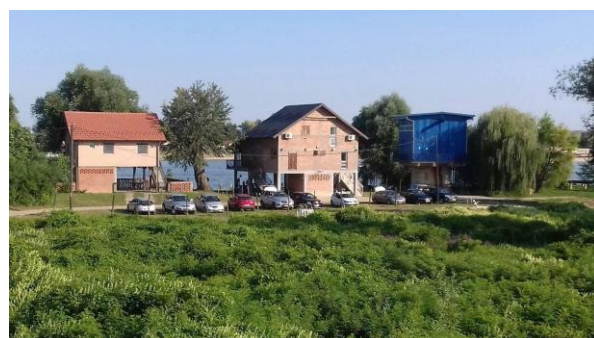
Slika 4: Nelegalno sagrađene kuće u neposrednoj zoni zaštite neposredno kraj bunara (desno)
