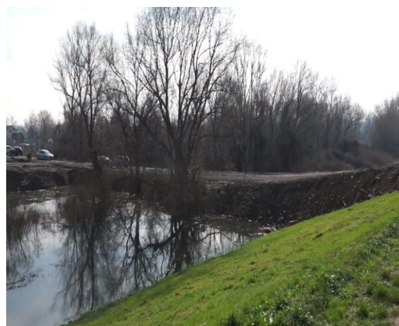
Slika 8: Jedan od ilegalno sagrađenih poprečnih nasipa preko inundacije. Oslonjeni na savski zaštitni nasip oni radikalno pogoršavaju protok velikih voda Save, pa čak usmeravaju struju velike voda na zaštitni nasip.
