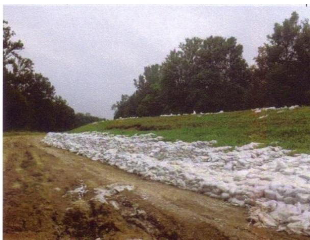
Slika 9. Privremena zaštita nizvodne nožice od hidrauličkog sloma i podlokavanja kosine
