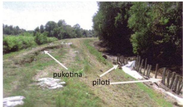
Slika 11. Ojačanje nožice kosine drvenim pilotima, vidi se pukotina na kruni nasipa
