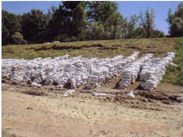
Slika 10. Opterećenje nizvodne kosine kao mjera sprečavanja klizanja
