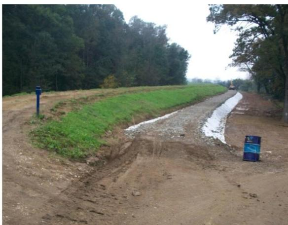
Slika 26. Trajna sanacija odrona dodavanjem drena s kontroliranim odvodom vode
