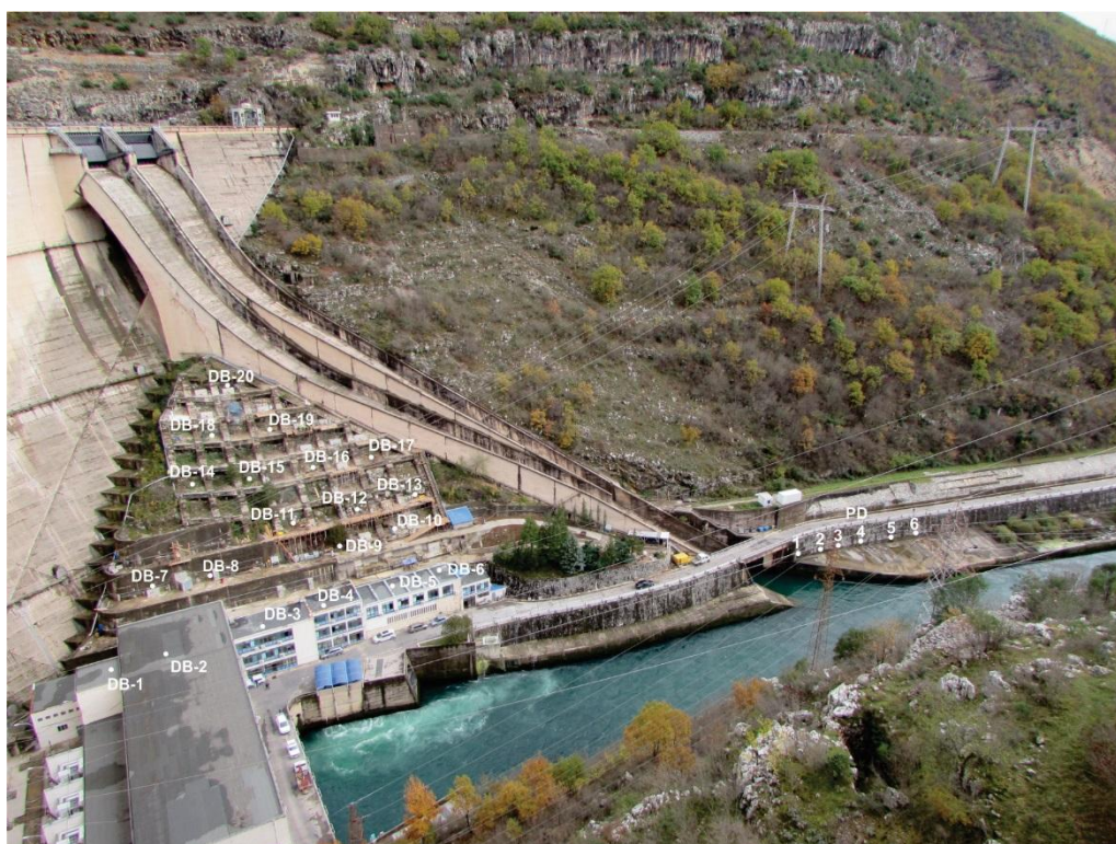
Slika 1. Ankersko polje na brani Grančarevo (Trebinje) sa položajem drenažnih bušotina
