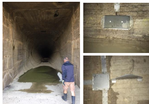
Slika 3. Merni sistemi u okviru derivacionog tunela Dabarsko polje – Fatničko polje: Izlazno/Ulazna građevina u Fatničkom Polju (Levo); Veliki ravni EM senzor u okviru osnovnog mernog sistema (Desno, gore); EM senzor „Ajkulino krilo“ u okviru kontrolnog mernog sistema (Desno, dole)
