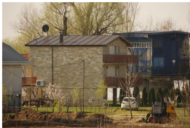
Slika 13. Nelegalne kuće uz reni bunara u neposrednoj zoni zaštite izvorišta Beogradskog vodovoda
