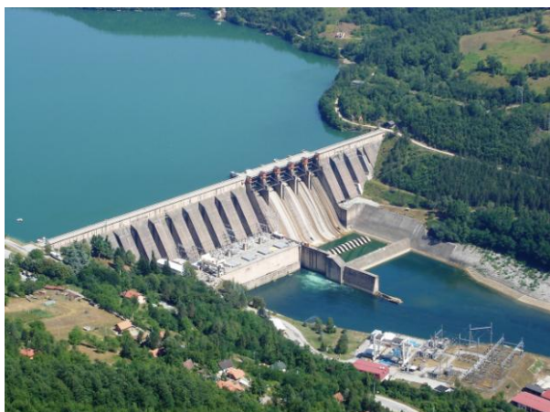
Slika 6. Brana i pribranska HE Bajina Bašta i mašinska zgrada istoimene RHE (dole desno)
