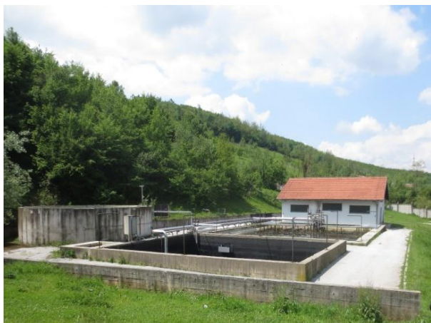
Slika 3. Objekti starog MBR uređaja za tretman procjednih voda na sarajevskoj deponiji
