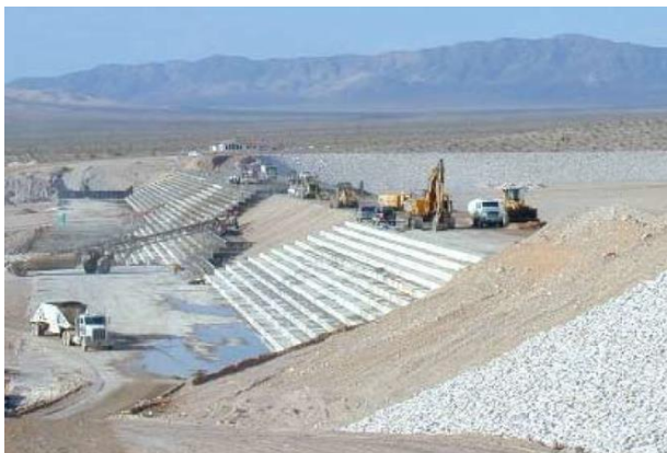
Slika 4.1 - Stepenasti preliv na nizvodnom licu nasute brane
