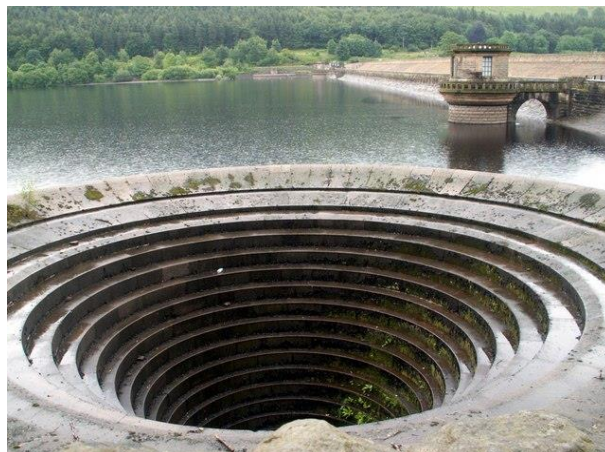
Slika 4.4 Stepenasti šahtni preliv brane Ladybower
