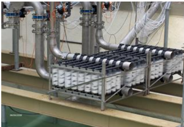
Slika 7. Membranski moduli pri montaži u bazen 2
