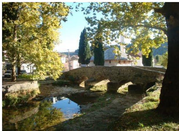
Slika 10: Reka Bregava u malovodnom periodu. Zapaža se vrlo mali protok, urbano, ekološki i ambijentalno neprikladan
