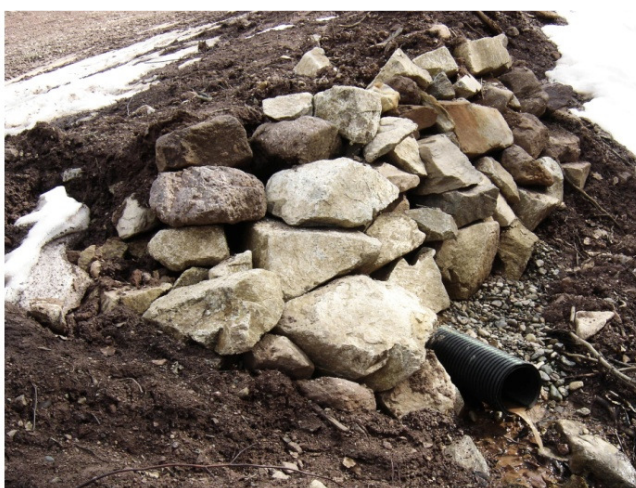
Слика 8. Стабилизационо-дренажна конструкција (излив; ски-стаза „Коњарник 1“, Октобар 2008)
