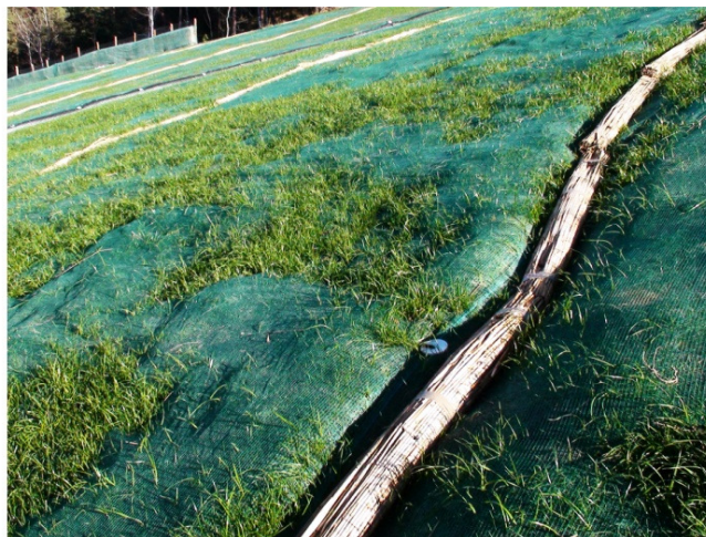
Слика 10. Контурни стабилизатори (баријере) за контролу брзог површинског отицаја (ски-стаза „Коњарник 1“, јуни 2009)
