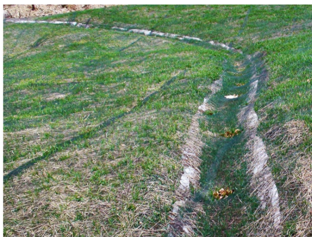
Слика 11. Површинска дренажа (ски-стаза „Коњарник 1“, Октобар 2008.)
