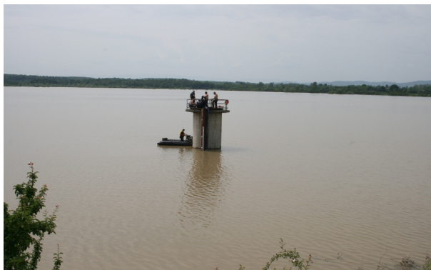
Kula zatvaračnica temeljnog ispusta
