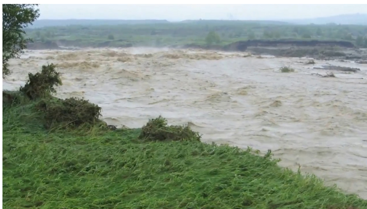
Ulivanje reke Kolubare u kop Tamnava istočno polje, na mestu proboja novog zaštitnog nasipa koji je nebrigom ostavljen niži 2 m u odnosu na nasipe koji su činili celinu za odbranu kopova od hiljadugodišnje velike vode
