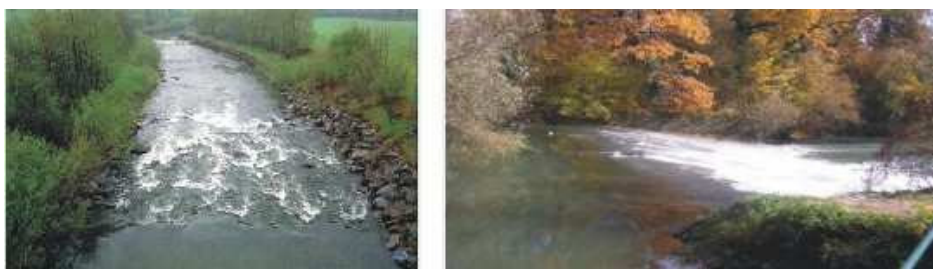
Slika 2. Smanjenja uzdužnog nagiba rečnog korita pomoću rampi; levo: pogled nizvodno na rampu u koritu reke Murr (pritoke reke Neckar) u Nemačkoj [3]; desno: betonska rampa na reci Karaš.
