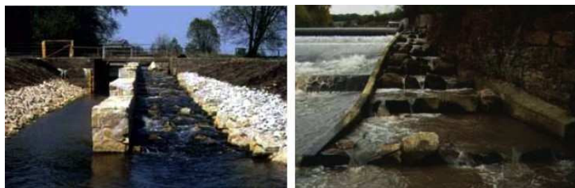
Slika 6. Primeri ribljih rampi na rekama Doln (Dölln) i Fils (Fils) u Nemačkoj [2].
