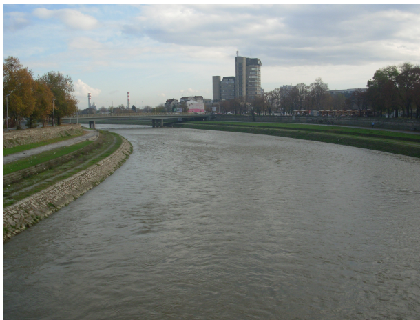
Slika 9. Reka Vardar nakon regulacije 1975 sa osnovnim koritom i koritom za veliku vodu rešenim na urbano prikladno načim
