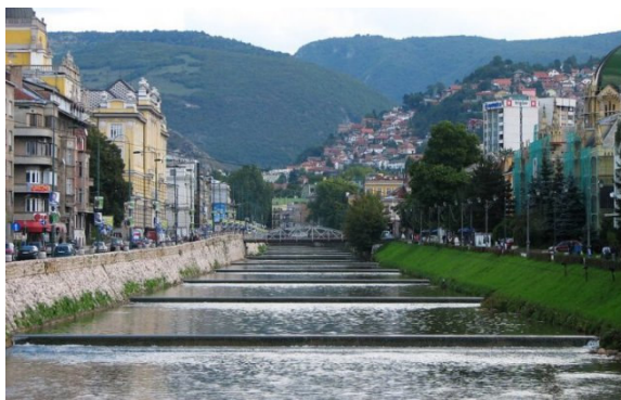
Slika 14. Miljacka u Sarajevu sa pragovima estetske i funkcionalne namene
