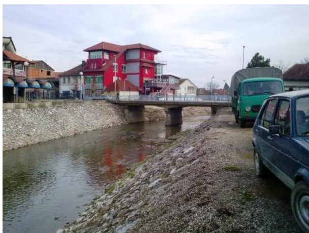
Slika 6. Regulacija reke Janje u mestu Janja, primer čisto funkcionalne, krajnje nehumane regulacije
