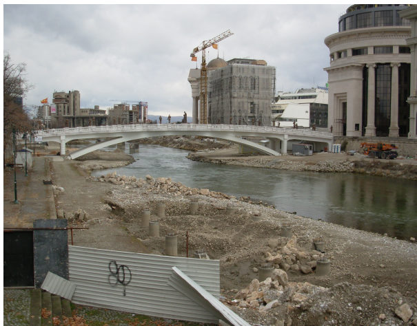
Slika 10. Zatvaranje rečnog koridora u centru Skoplja visokim zgradama koje ulaze u nekadašnje korito za veliku vodu.
