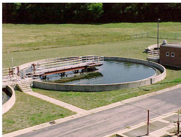
Slika 4. Primer sedimentacionog bazena
