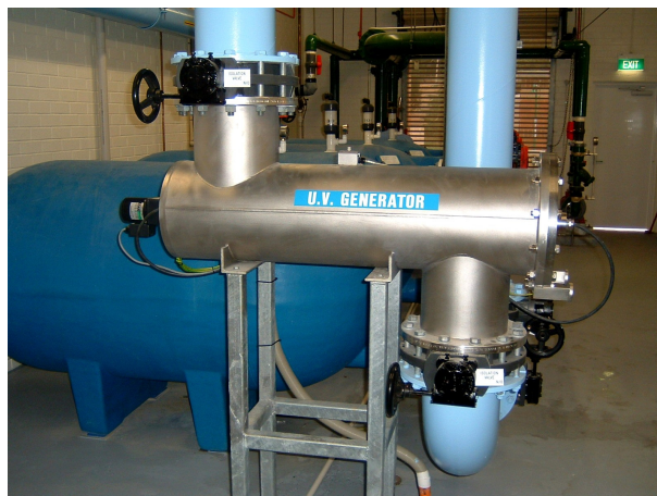
Slika 6. Tipično postrojenje za dezinfekciju ultraljubičastim zracima
