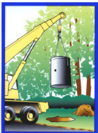
Slika 8. Instalacija sabirnog šahta sa kanalizacionom pumpom opremljenom seckalicom
