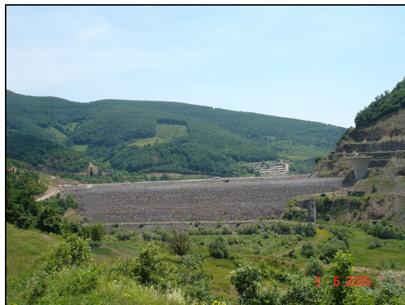
Sl.1. Brana „Selova“ u izgradnji
