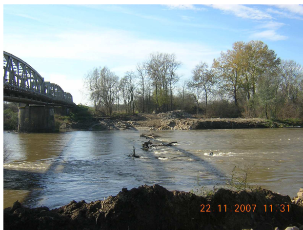
Slika 1. Položaj projektovanog praga u koritu Velike Morave (km 91+067) i mesto njegove izgradnje, na početku radova [4].
