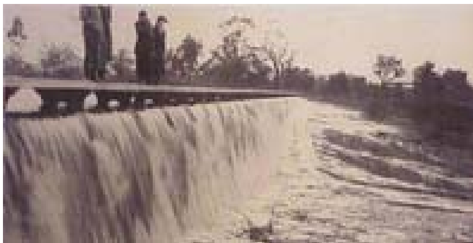
Слика 35. Прелив у продужетку гравитационе бетонске бране “Гослинг Крик” [23]
