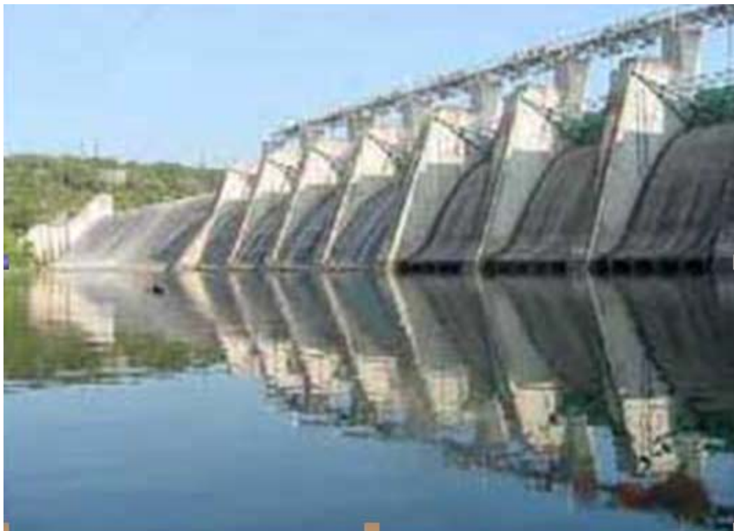
Слика 45. Поглед на нову брану „Том Милер“ која је саграђена на месту старих брана. На њој се види слободан прелив и прелив са сегментним уставама
