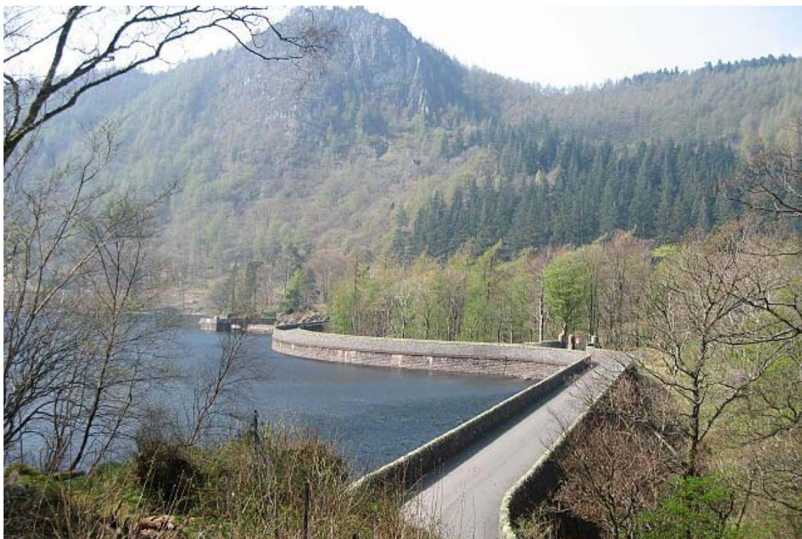
Слика 46. Поглед на праволинијски прелив и залучену гравитациону бетонску брану “Тирлмир” [32]
