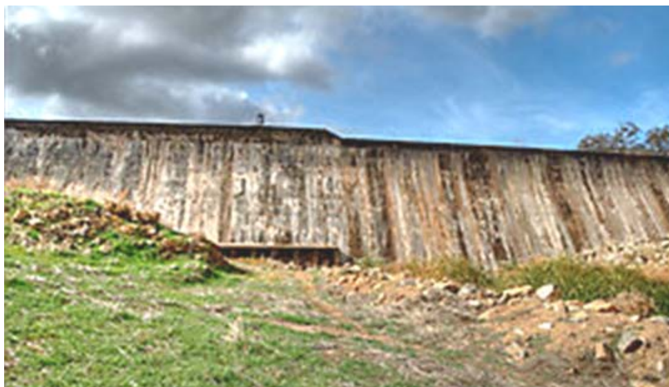
Слика 49. Низводна страна гравитационе бетонске бране „Бетунгра“ [33]
