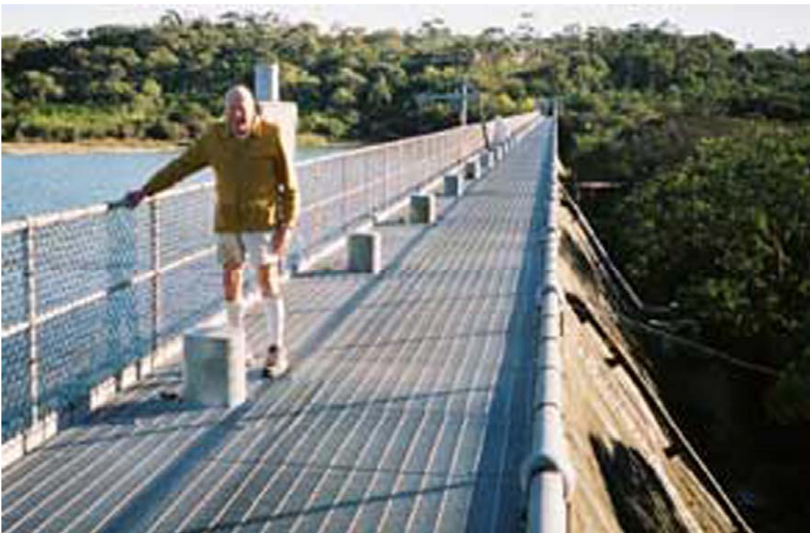
Слика 40. Поглед на круну гравитационе бетонске бране “Менли” [28]
