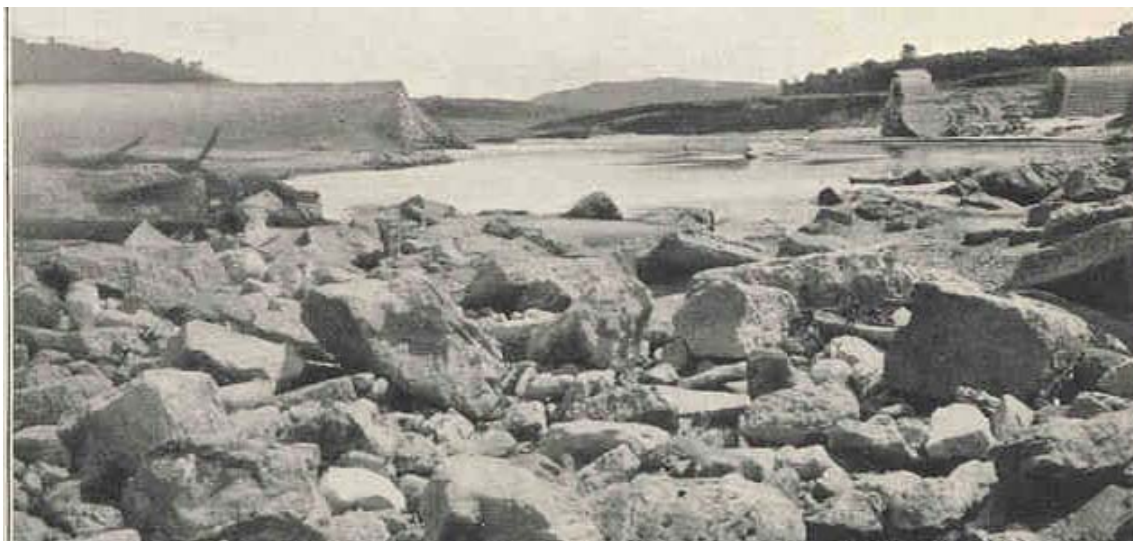
Слика 43. Поглед на делове прелива гравитационе бетонске бране „Остин“ неколико дана пошто је прошао поплазни талас који је 7. 4. 1900. године порушио брану и хидроектрану. (фото James D.)
