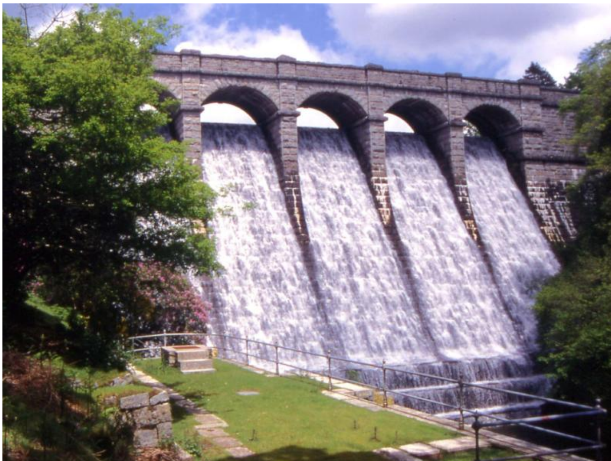
Слика 55. Виде се свих пет преливних поља и масивни лучни мост преко њих [39]
