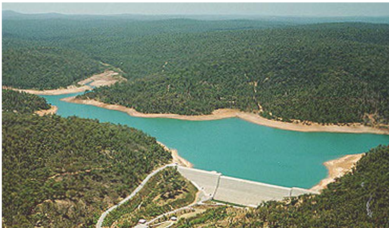
Слика 38. Поглед на целу акумулацију и гравитациону бетонску брану “Нова Викторија” [26].
