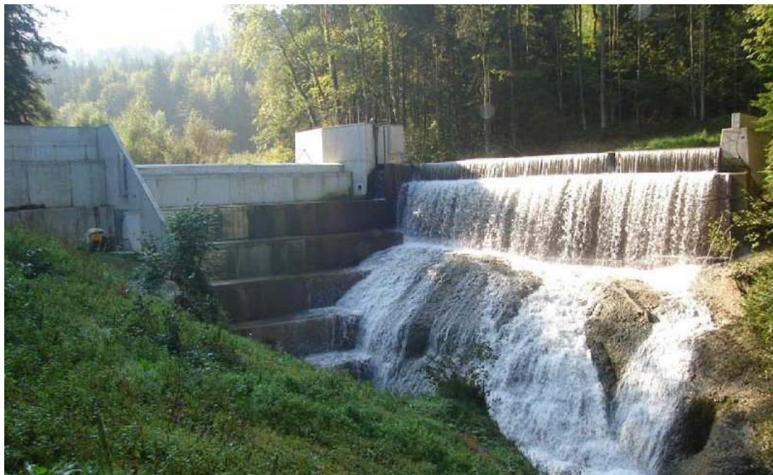
Слика 41. Поглед на гравитациону бетонску брану „Бучхолц“ на слици десно, а на слици лево је прелив (са Интернета, File 060929 KW Buchholz 001)
