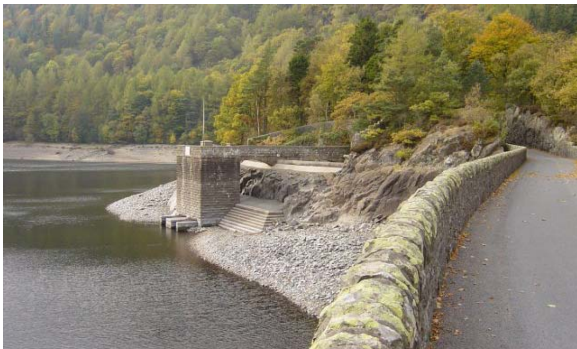
Слика 47. Затварачница водозахватне грађевине и гравитациона бетонска брана “Тирлмир” [32]
