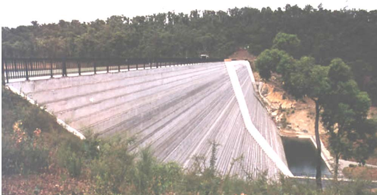
Слика 37. Поглед на гравитациону бетонску брану “Нова Викторија”, саграђену 1991. године [25].
