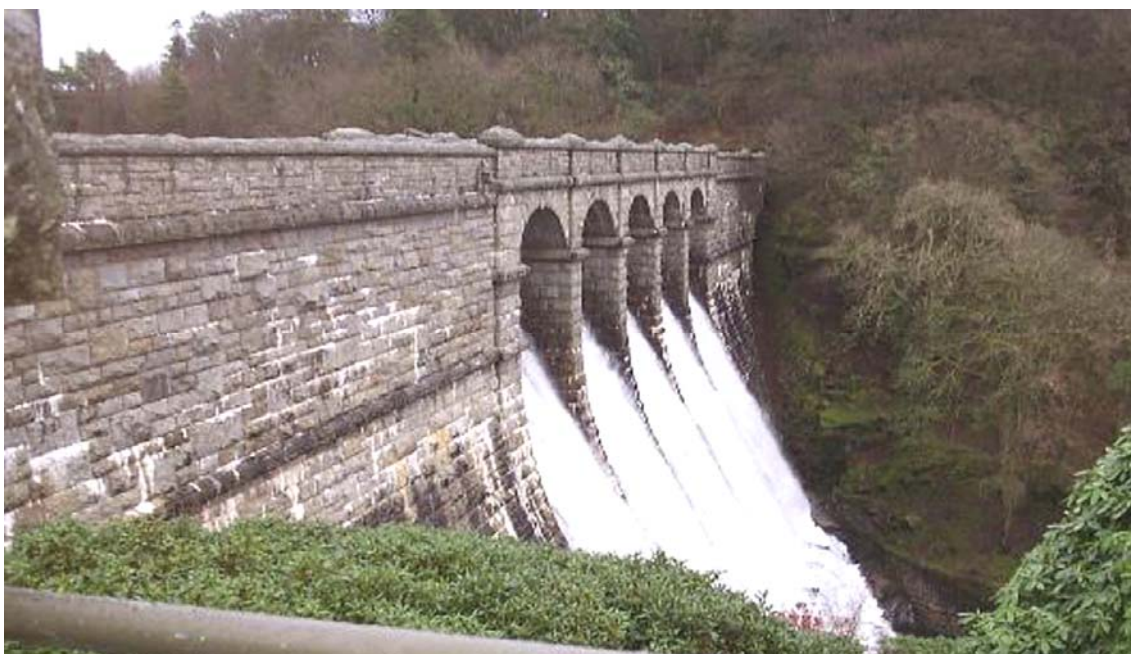
Слика 54. Поглед на низводну страну гравитационе бетонске бране “Буратор” кад прелив ради [38]
