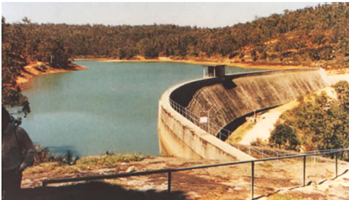
Слика 36. Поглед на гравитациону бетонску брану “Викторија” [25]
