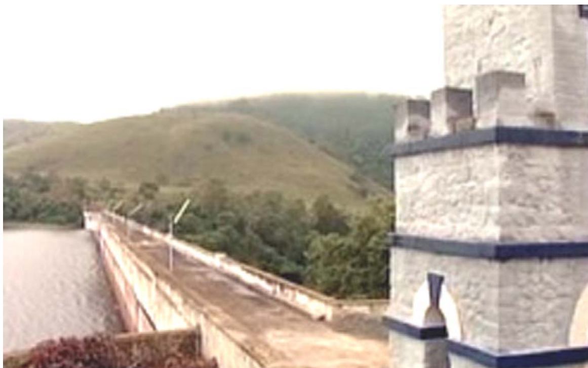
Слика 51. Приказује узводну леву страну са круном гравитационе бетонске бране “Перијар” [35]
