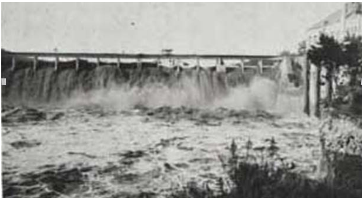
Слика 44. Друга гравитациона бетонска брана “Остин” је саграђена на месту бране из 1893. године. Изграђен је мост преко прелива и 57 табластих затварача од дрвета (Интернет, History of Tom Miller Dam)
