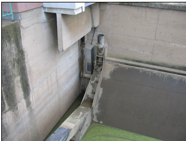
Fotografija 4: Segmentni zatvarač na ustavi "Novi Bečej" sa prikazom konstrukcije za ovazdušenje
