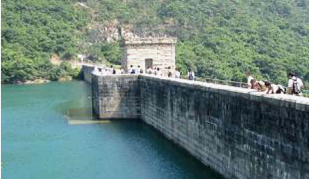
Слика 14. Поглед на гравитациону бетонску брану “Апер Таи Там” после надвишења бране 1897. године [14].
