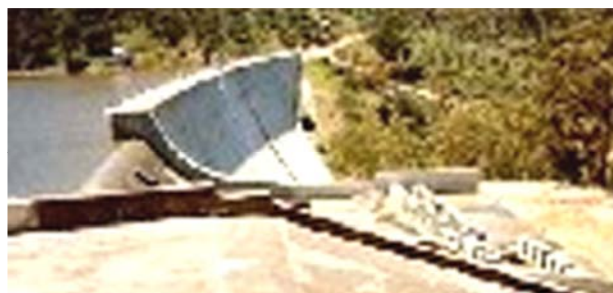
Слика 34. Поглед на гравитациону бетонску брану “Биталу”, саграђену 1890. године у Аустралији. Фотографија је начињена скоро сто година после завршетка бране [22].
