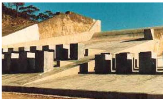
Слика 33. Садашњи прелив саграђен 1986. г. Први прелив из 1890. г. издигнут је 1927. г. за 74 cm. Прелив из 1979. г. је спуштен за 30 cm, да би 1986. г. део прелива био спуштен за још 100 cm [21].
