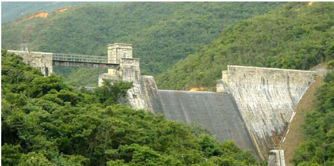
Слика 13. Поглед на прелив и гравитациону бетонску брану “Апер Таи Там” после надвишења бране 1897. године [14].
