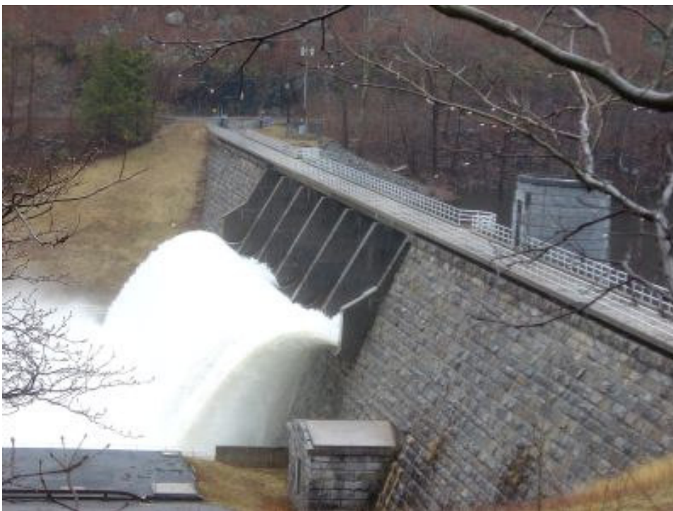
Слика 10. Поглед на нову гравитациону бетонску брану “Бојдс Корнер” изграђену на истом месту 1990. године [11].
