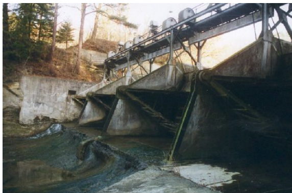
Слика 7. Поглед на четири преливна поља (која су касније порушена) и мост преко њих. На левој страни се види део бране која је саграђена 1872. године [9].
