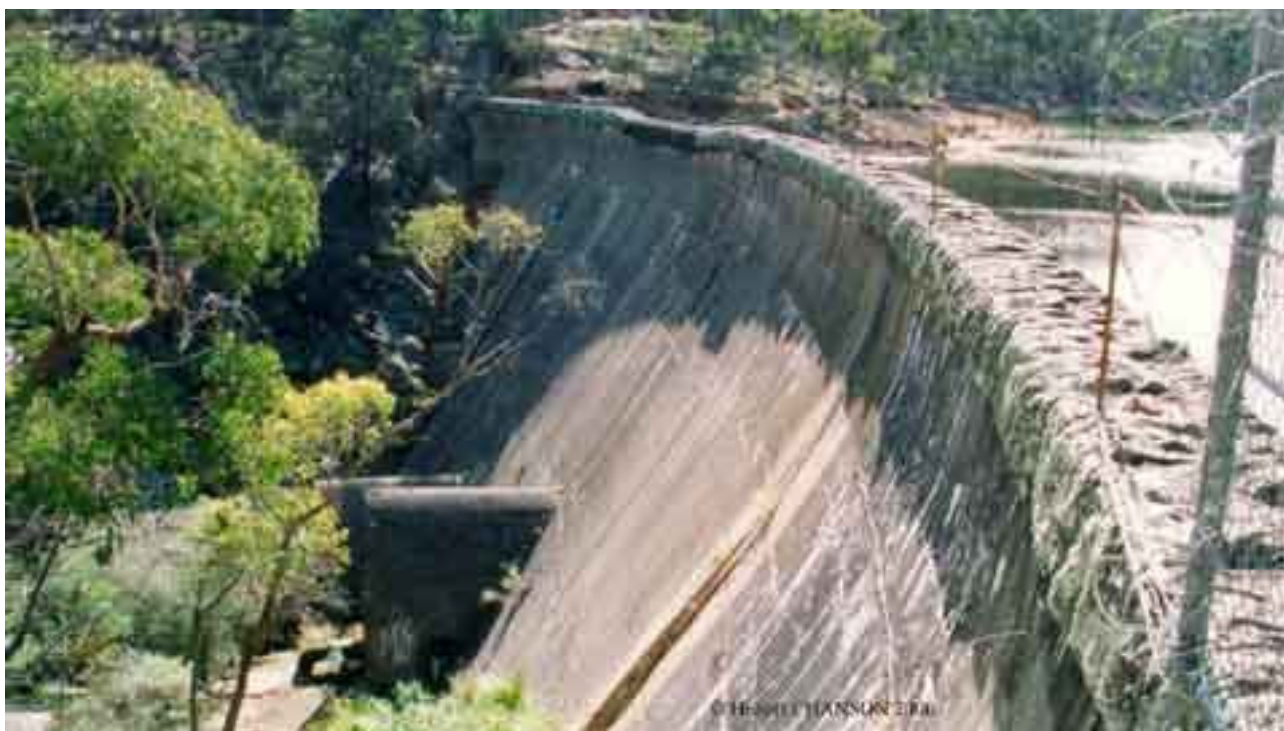
Слика 11. Поглед на гравитациону бетонску брану “Лоуер Стони Крик”, која је изграђена ради снабдевања водом града Гилонга [12].
