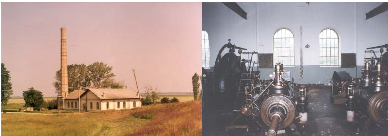
Slika 2: Crpna stanica sa parnom pumpom u žabaljskom ritu na obali Tise, građena 1898. godine
