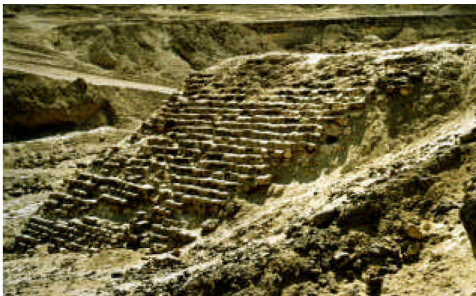
Слика 9. Поглед на узводну десну страну бране „Кафара“. Види се лева страна а на десној добро очувана камена облога, као и простор где је била средина бране. Узето са Интернета, сајт Sadd el-Kafara: the worlds oldest large dam.
