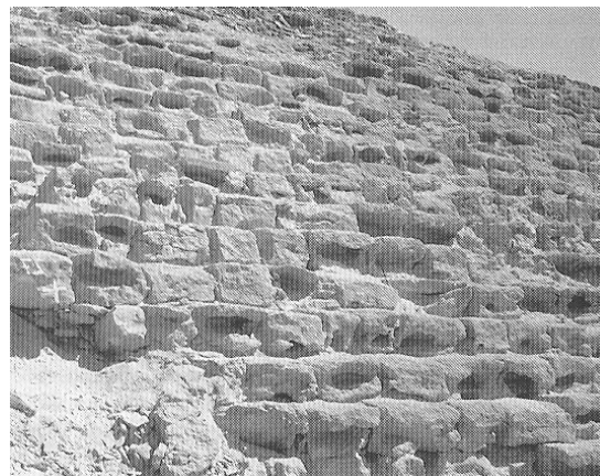
Слика 10. Поглед из близине на десну узводну страну бране „Кафара“ са добро очуваним каменим блоковима. Узето са Интернета: Photo g. Garbrecht, Lages-büttel/D, лит. [3].
